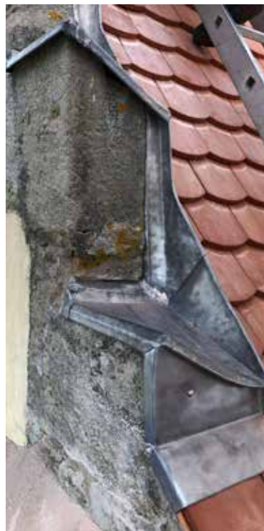
Der Anschluss zwischen Staffelgiebel und Turmdach wird abgedichtet
