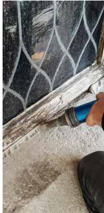
Fenster werden neu abgekittet
