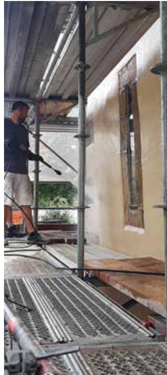
Die Kirchturmfassade wird abgedampft
