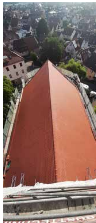
Das Dach des Kirchenschiffs ist gedeckt
