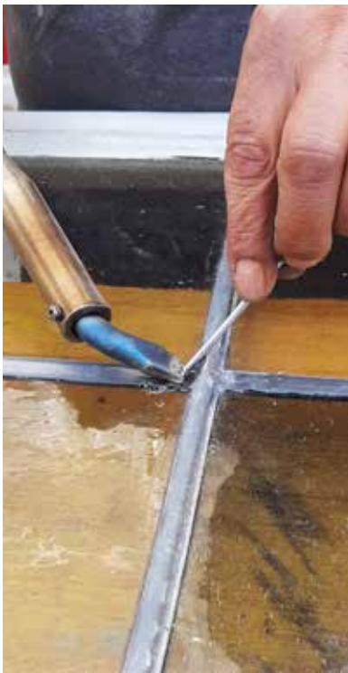
Bleibrüche werden gelötet
