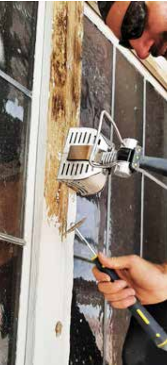
Die Fenster werden von mehreren Schichten Lack befreit
